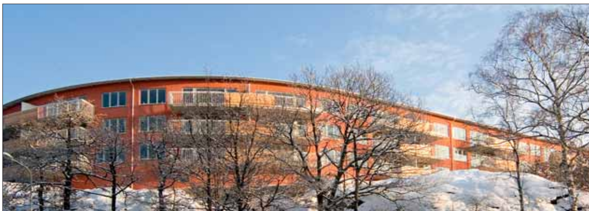
New construction in Guldheden.
